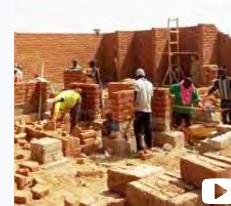
SÉNÉGAL, FAWROU REMOBE, CONSTRUCTION DU 2 e GRENIER
